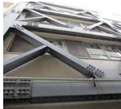
▲平成 19 年 _ 第一保育園耐震工事完了
