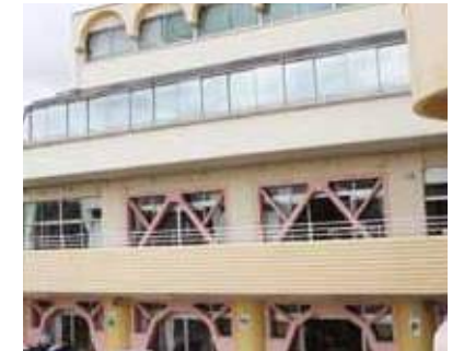
▲平成 26 年 _ 第二保育園 耐震工事完了
